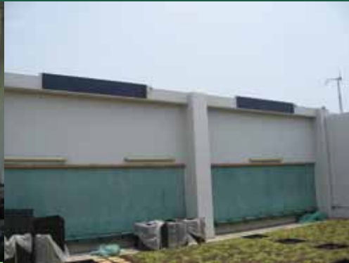
Solar panels 太陽能板
